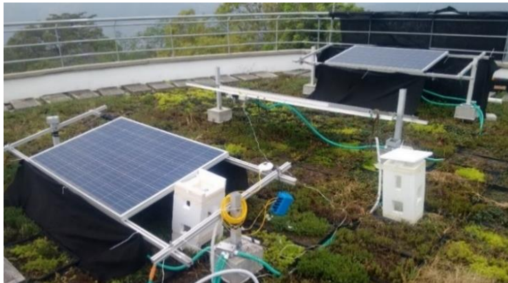
Figura 27. Mecanismo para el control del viento en GRIPV #1
