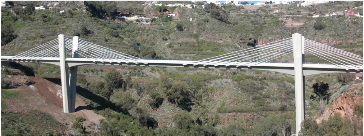
Figura 2. Puente con pretensado extradosado (Viaducto de Teror, Gran Canaria, España).
