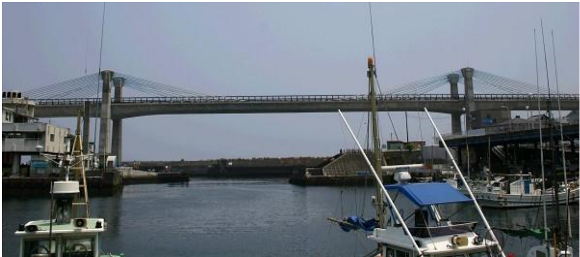
Figura 4. Puente Odawara Blue Way, Japón. Tomado de http://en.structurae.de/photos/index.cfm?JS=41476
