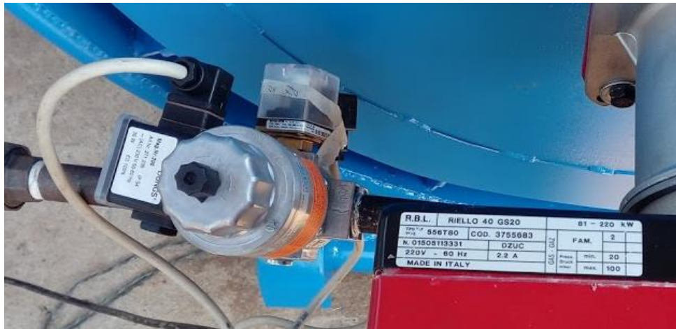
Figura 28. Electro válvula quemador Riello 40 GS 20
