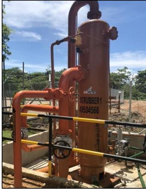
*Figura 10.* Scrubber de gas estación Auxiliar Cantagallo
