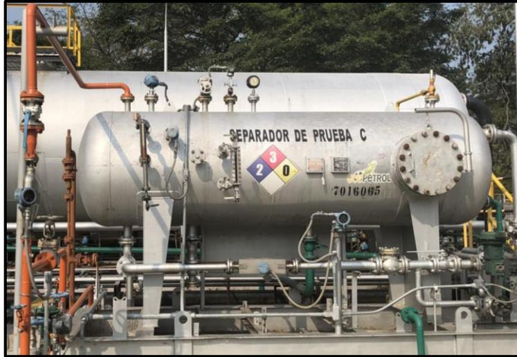
Figura 9. Separador de prueba ERTC-3.
