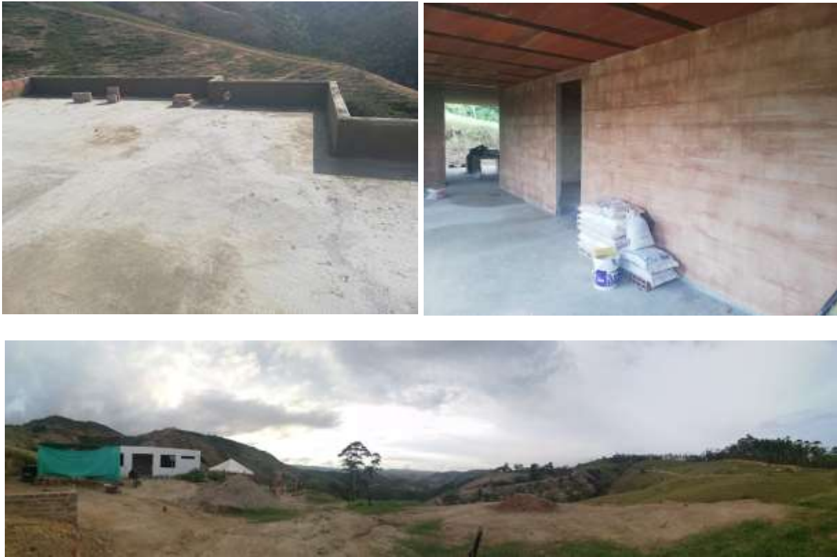
Figura 40. Avance de la obra de LLANO GRANDE
