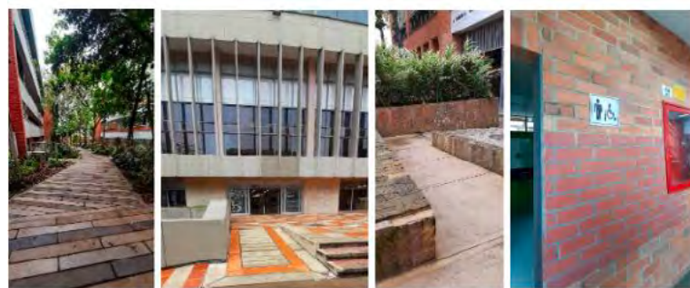
Figura: Collage - Rampas y señalización existentes en Escuela de Música, Biblioteca y Ciencias Humanas I Fuente: Registro fotográfico 2025
