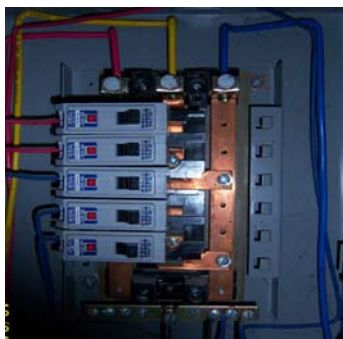
Figura 20. Barraje del tablero TQ
