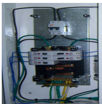
Figura 16. Barraje del tablero TL
