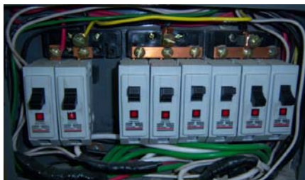
Figura 31. Barraje del tablero TBV
