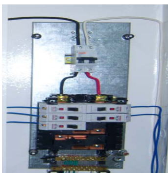
Figura 15. Barraje del tablero TM
