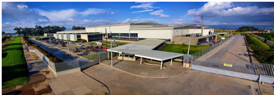
Figura 1. Planta de Producción PVC Gerfor Colombia en Cota, Cundinamarca
