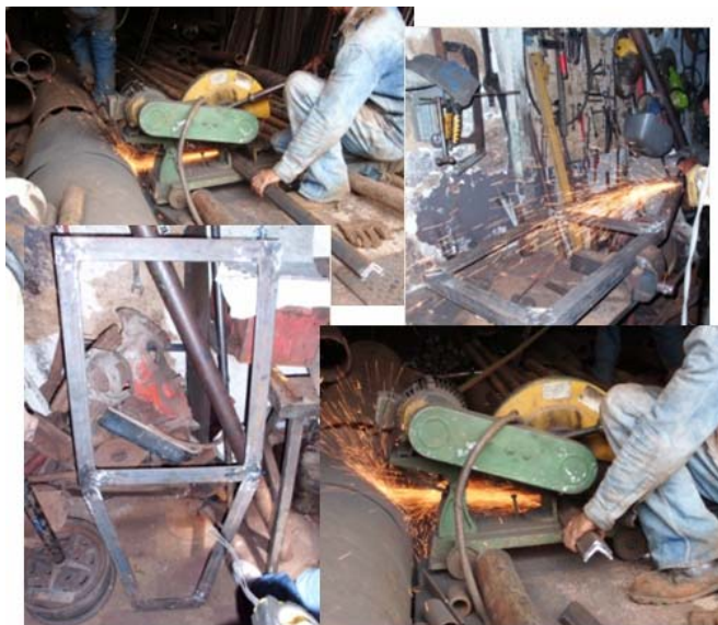
Figura 53: Corte y soldadura de ángulos, parte superior de la base.
