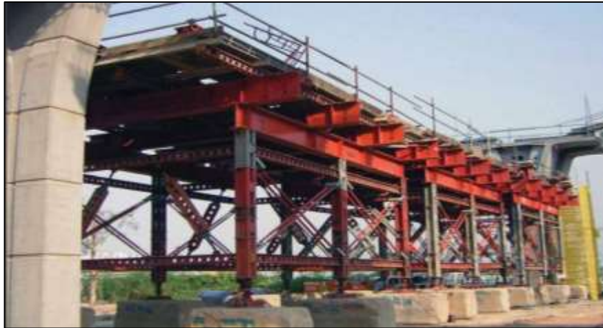
Fotografía 3: Sistema de cimbras en el suelo in situ.
