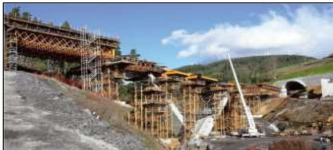
Fotografía 1: Construcción In situ
