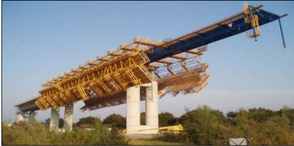
Fotografía 2: Sistema constructivo in situ SMMS
