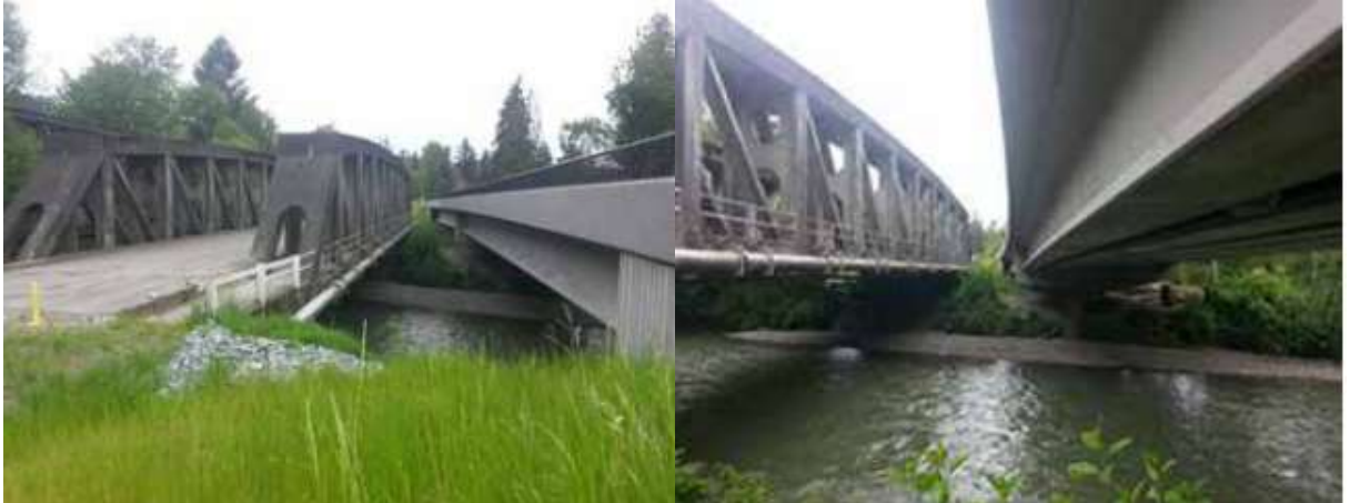
Fotografía 8: Puente McMillin y State route 162/6 puyalluo river bridge
