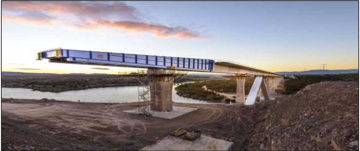
Fotografía 5: Puente la marquesa, Cd De México, México
