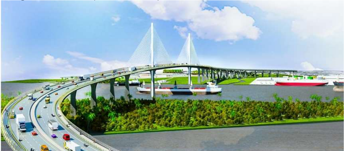
Fotografía 13: Nuevo puente Pumarejo
