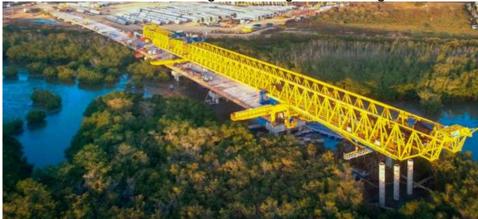
Fotografía 12: Viaducto sobre ciénaga de la virgen en Cartagena
