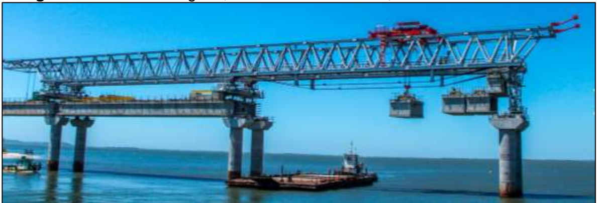
Fotografía 4: Puente la laguna, Estado santa catarina, Brasil
