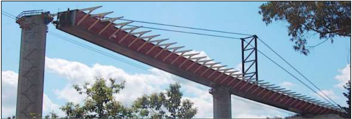
Fotografía 6: Viaducto del Regueirón, Asturias, España
