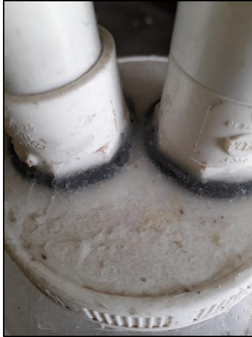
Figura 33. Sellamiento de fugas de gas
