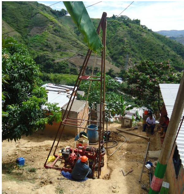
Figura 43. Realización sondeo No.2.
