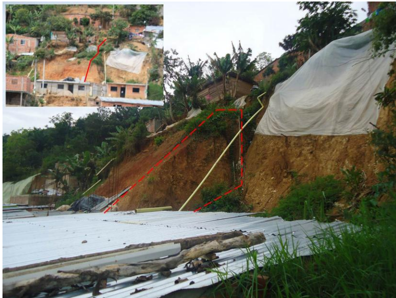
Figura 34. Deslizamiento típico en la zona estudiada (movimiento de cuña completa).
