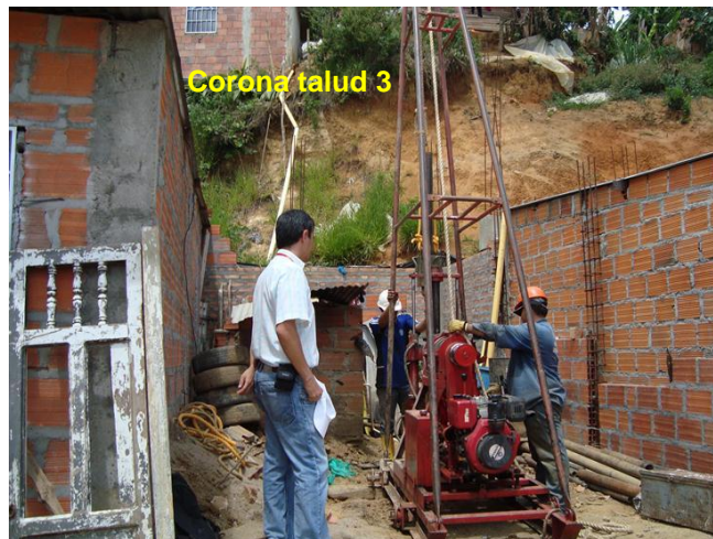
Figura 41. Realización Sondeo No.1
