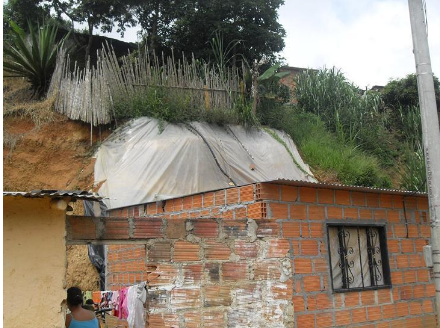
Figura 7. Sector Talud derecho zona de estudio, abril de 2010.
