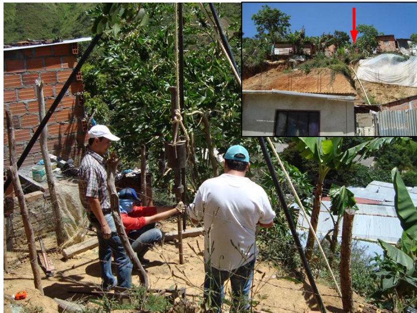
Figura 47. Realización sondeo No.4.
