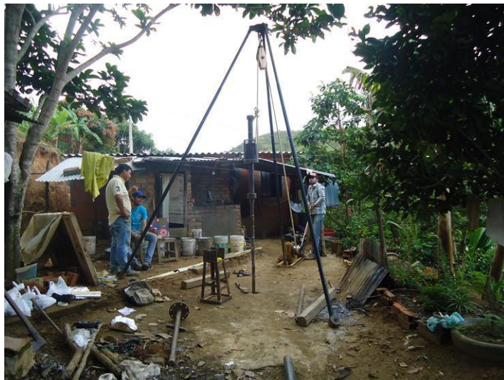
Figura 45. Realización sondeo No. 3.
