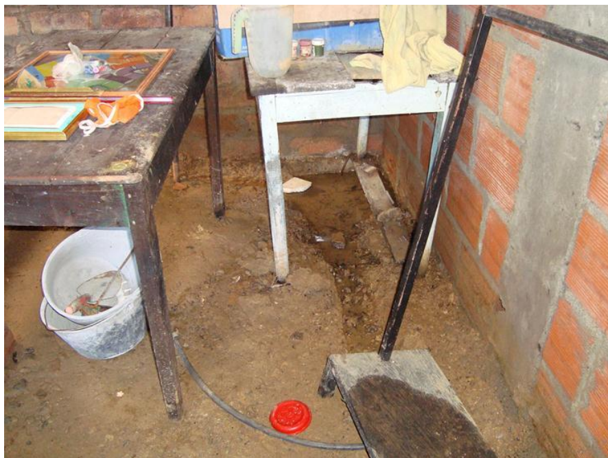
Figura 14. Presencia de agua en las casas del pie del talud.
