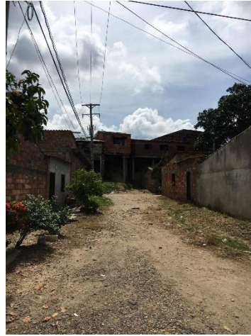
Imagen 8. Calle 75A tramo 2 (3) Fuente: Autores
