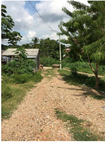
Imagen 11. Calle 76 tramo 1 Fuente: Autores
