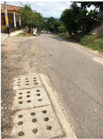
Imagen 4. Calle 75 tramo 9 (2) Fuente: Autores
