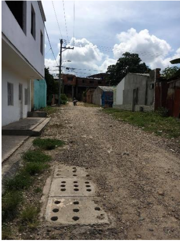
Imagen 7. Calle 75A tramo 2 (2) Fuente: Autores
