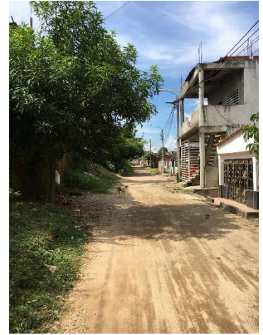
Imagen 21. Carrera 35B tramo 2. Fuente: Autores
