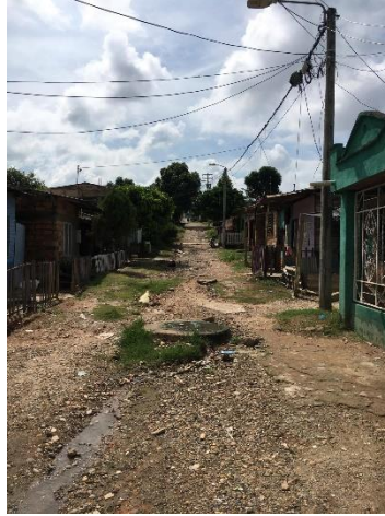
Imagen 2 Calle 75 tramo 1 (2) Fuente: Autores
