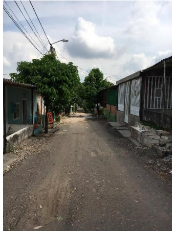
Imagen 17. Carrera 35 tramo 1 (2). Fuente: Autores
