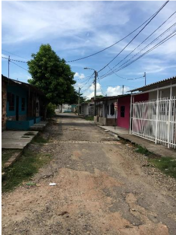
Imagen 16. Carrera 35 tramo 1 (1). Fuente: Autores
