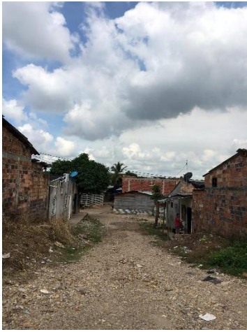
Imagen 10 Calle 75A tramo 2 (5) Fuente: Autores
