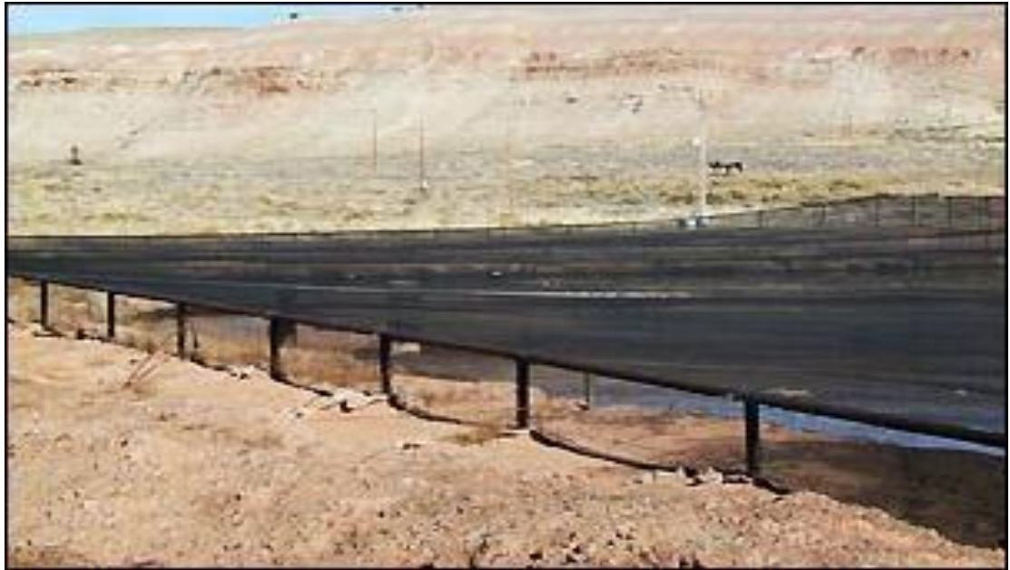
Figura 35. Estanque de Evaporación Cubierto con una Malla.
