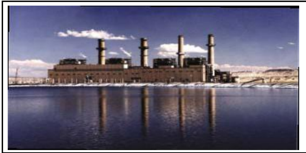
Figura 37. Central Eléctrica Alimentada con Carbón en Nuevo México, EUA.
