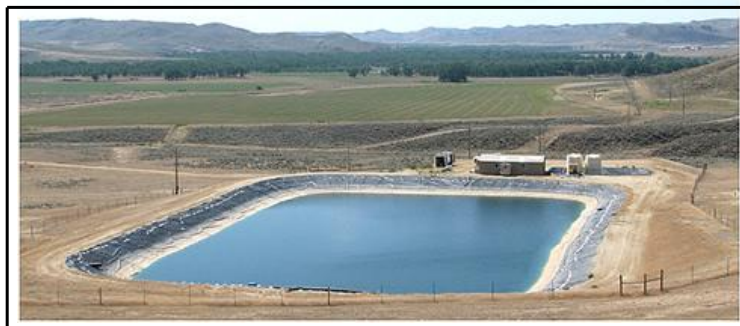
Figura 41. Sistema de Riego Subterráneo con Agua de Producción en BeneTerra.
