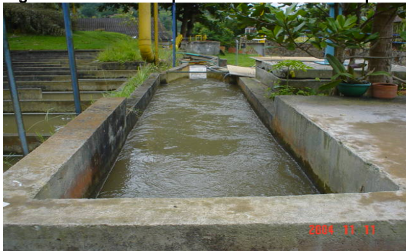
Fotografía 3. Canal de Aquietamiento. Sección Ampliación.
