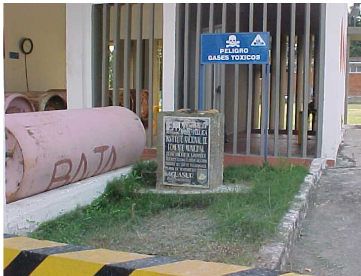
Fotografía 21. Caseta de Cloración
