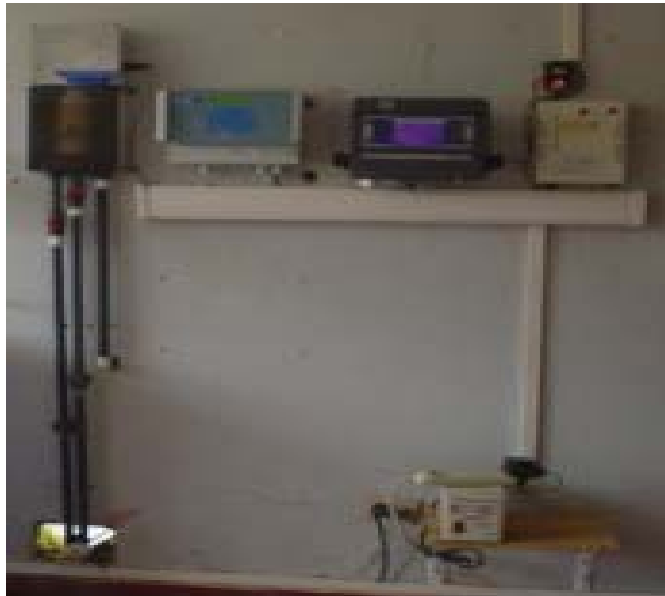
Fotografía 15. Equipo de Medición de Diferencia de Potencial Streaming Current. Sección Antigua.
