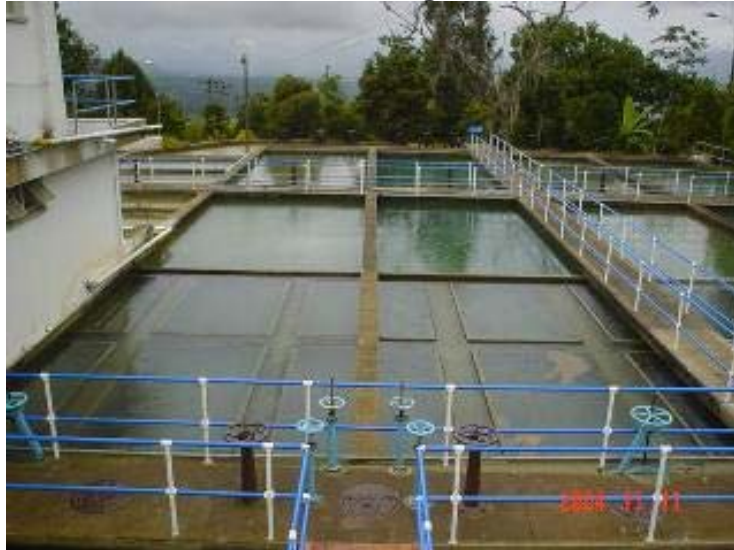
Fotografía 8. Sedimentadores Optimizados (Convencional – Placas). Sección Original.
