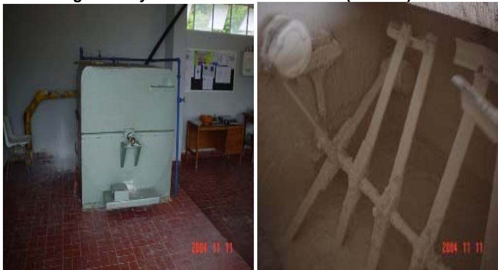
Fotografía 18 y 19. Mezclador de Solución (lechada) de Cal.
