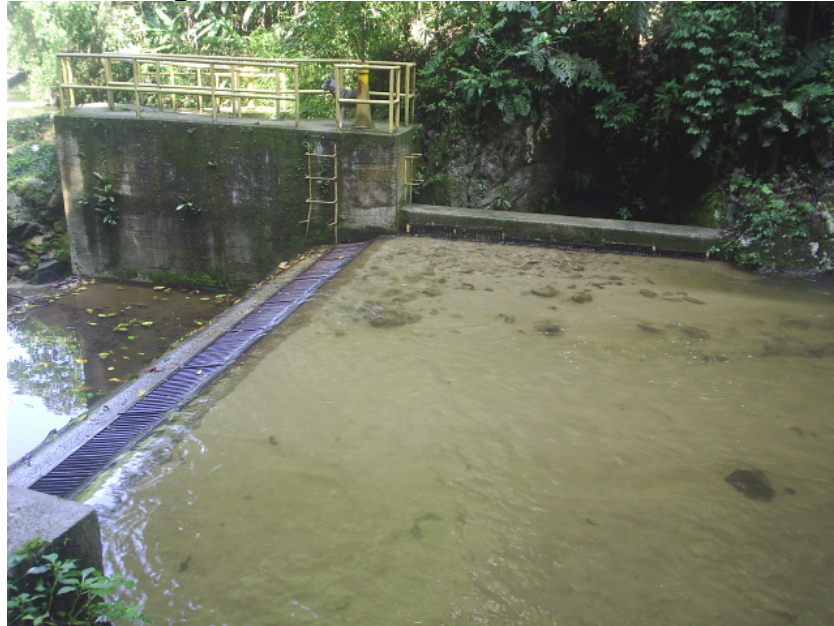
Fotografía 1. Bocatoma Lateral y de Fondo.
