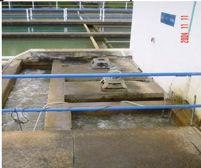
Fotografía 4. Cámaras de Mezcla Rápida. Sección Original.
