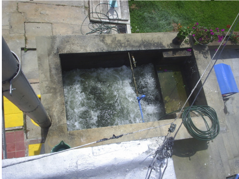
Fotografía 2. Cámara de Llegada. Sección Original.
