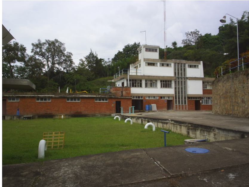
Fotografía 20. Vista de los tres Pisos del Edificio de la Planta.
