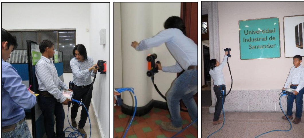
Figura 25. Inspección Geo-Radar en Vigas, Columnas y muros
