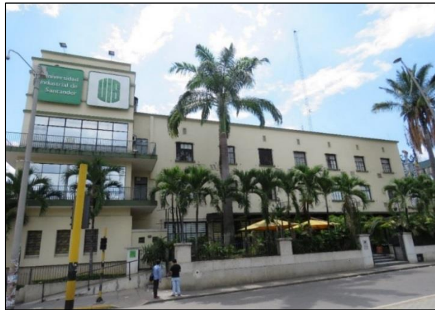
Figura 11. Fachada Este Edificio Bucarica UIS
