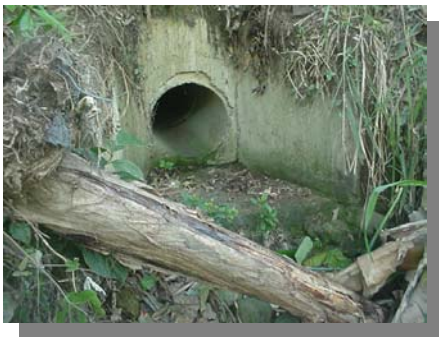
Entrega aguas lluvias Barrio Villaluz
