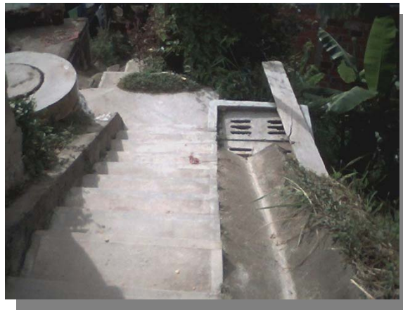
Foto 12. Canaletas recolectoras escorrentía superficial Omega II
