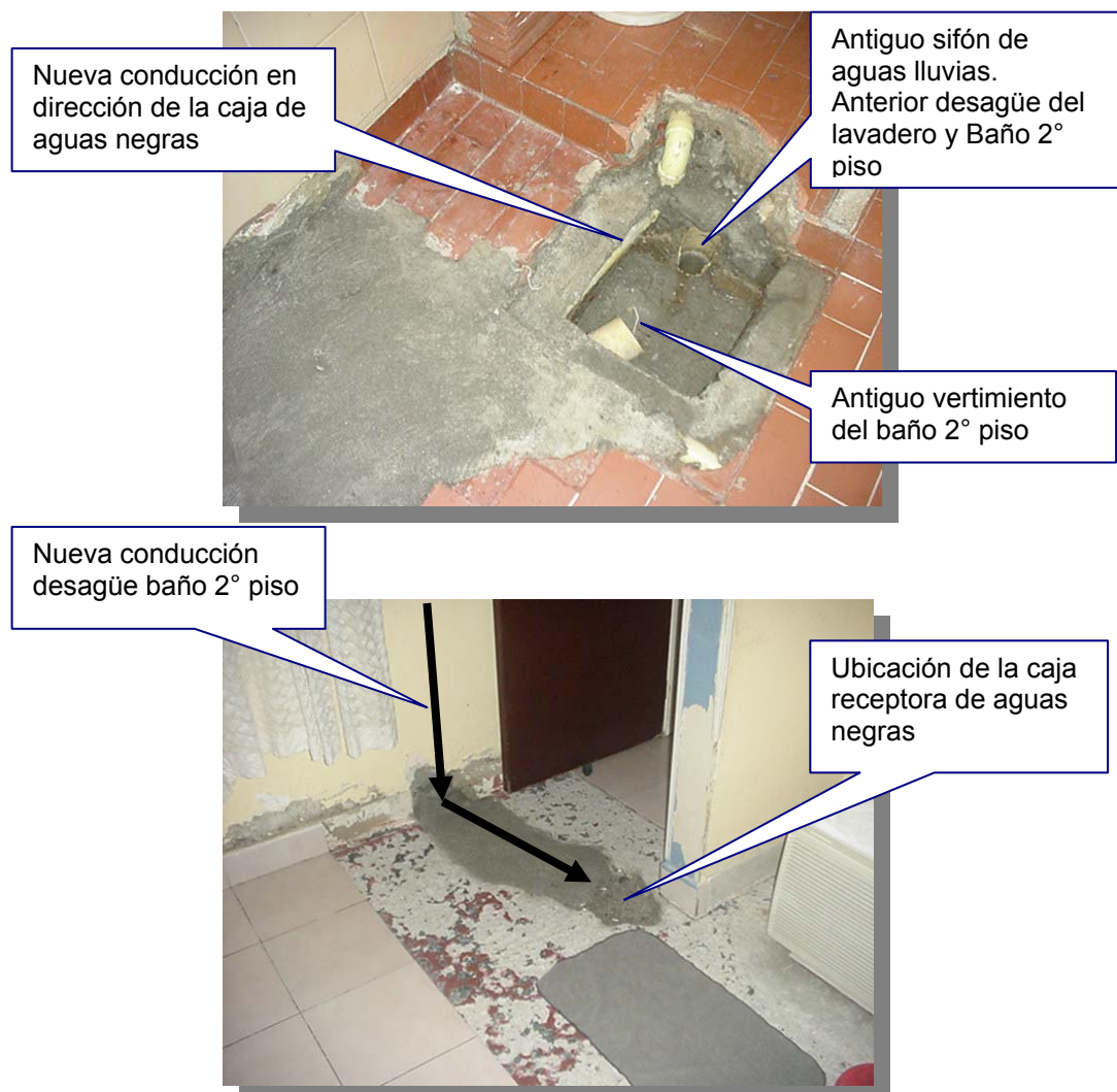
Foto 15. Arreglo conexión errada Urbanización Los Robles
