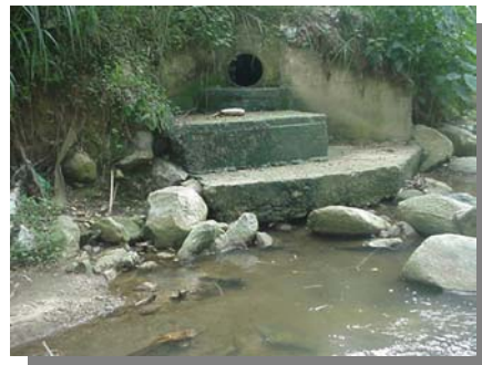
Entrega aguas lluvias Barrio las Villas
