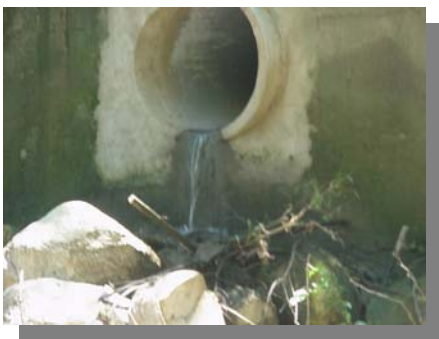
Entrega aguas lluvias Zapamanga V etapa
