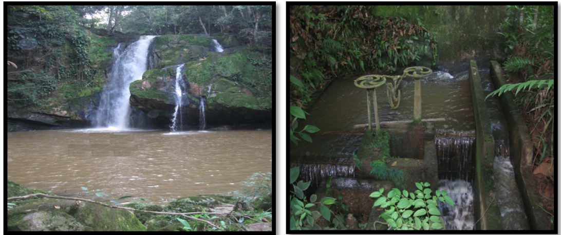
Figura 7. Bocatoma de la planta de tratamiento de agua potable.
