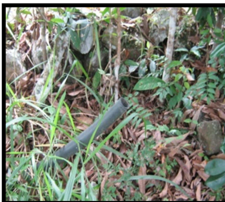
Figura 13. Vista de mangueras desde la quebrada a las viviendas zona norte municipio Icononzo.
