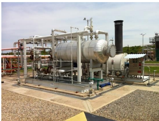
Figura 21. Calentador de aceite térmico (Heat médium)
