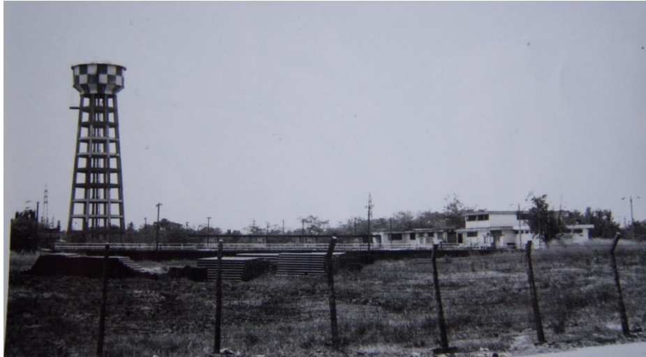
Fotografía 18. Torre de aeración
