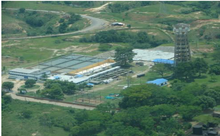
Fotografía 19. Planta de tratamiento
