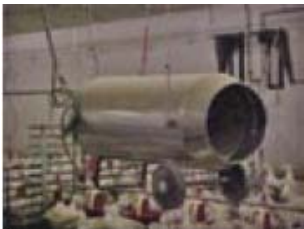
Figura 43. Canales de ventilación
