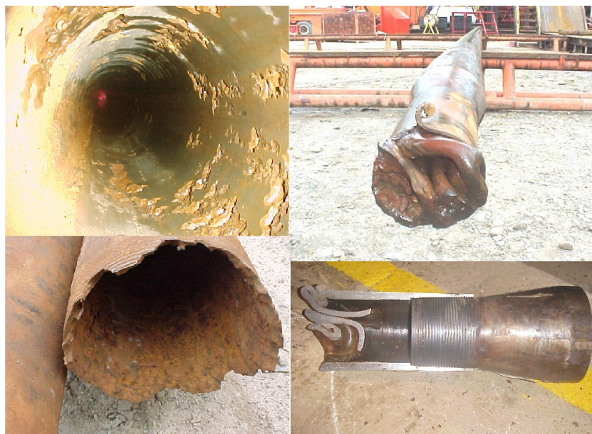
Figura 15 Tubería de producción recuperada debido a falla por corrosión de los fluidos de producción y posterior colapso.
