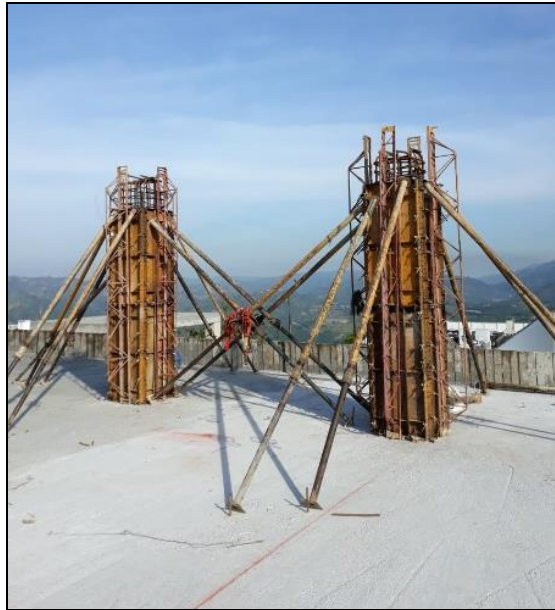
Figura 10. Encofrado de columnas para fundición.
