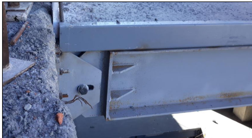
Figura 4. Detalle apoyo móvil de puente metálico.
