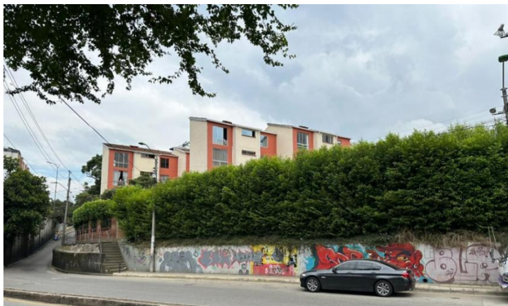
Figura 11: vista el lado occidental del muro que rodea al conjunto Portón del Tejar – Portería I. Actual extensión de la Carrera 33 de Bucaramanga.
