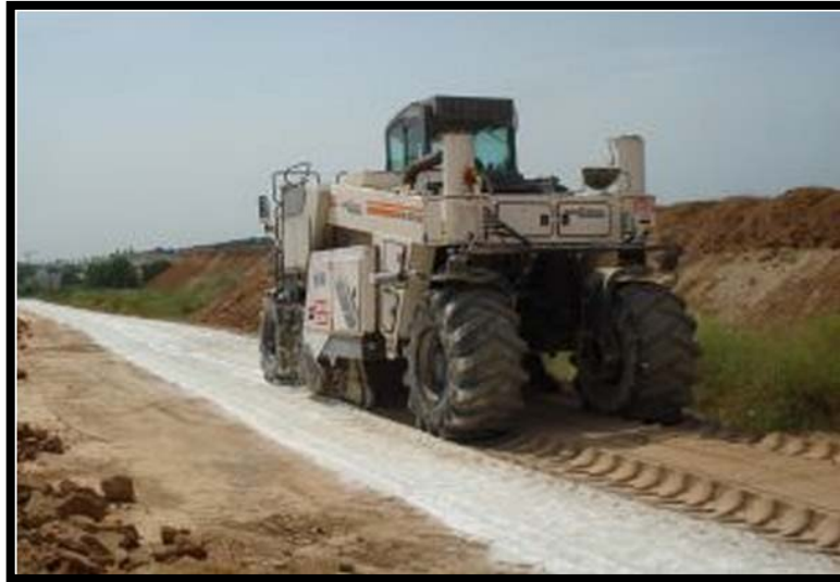
Figura 11. Proceso de estabilización con cal sobre una vía terciaria.
