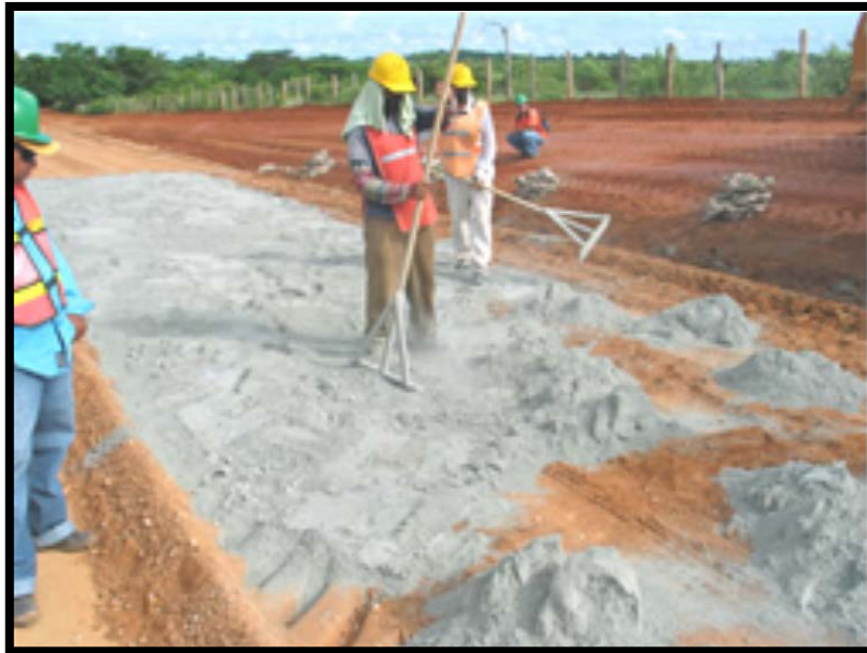
Figura 12. Estabilización química con la mezcla de suelo-cemento.
