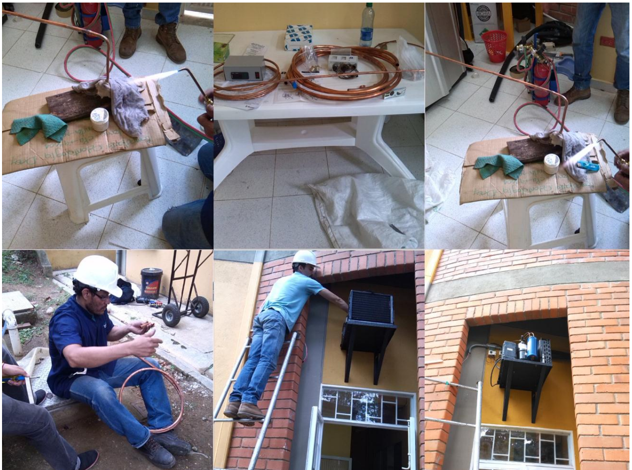
Figura 53. Instalación de Unidad Condensadora.
