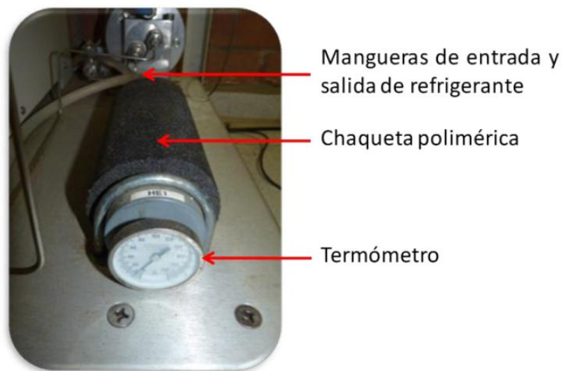
Figura 14. Intercambiador de Calor 1 (Enfriamiento).
