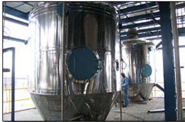
Figura 10. Evaporador Flubex para concentración de Vinaza
