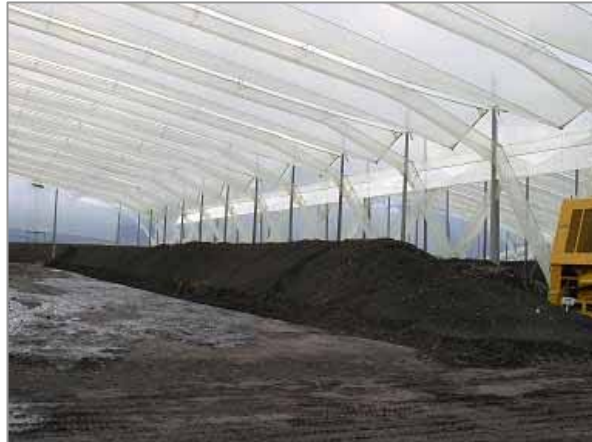
Figura 9. Planta de Compostaje, Ingenio INCAUCA S.A.
