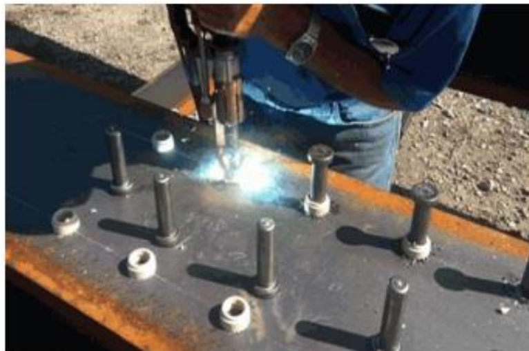
Figura 20. Instalación espigos con pistola auto perforante.
