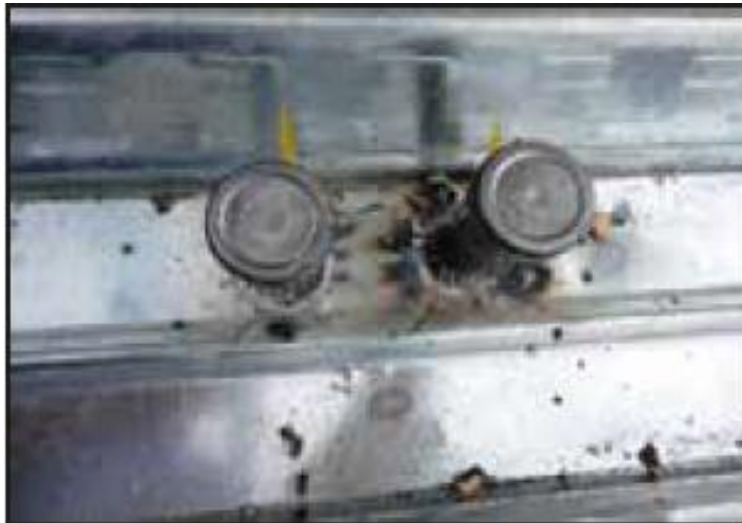
Figura 18. Conectores de cortante tipo espigo.
