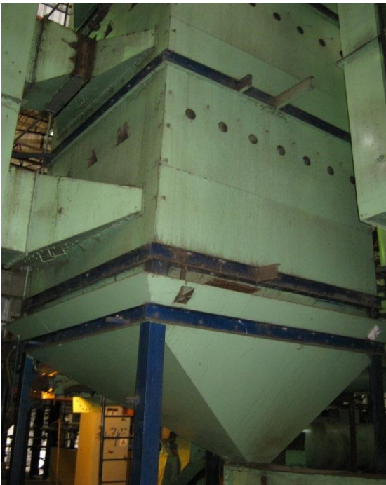
Ilustración 16. Vista frontal de un silo secador de nueces.
