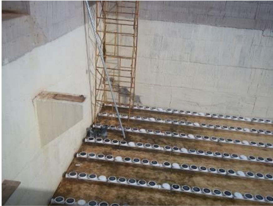
Figura 8. Disposición del sistema de extracción de lodos
