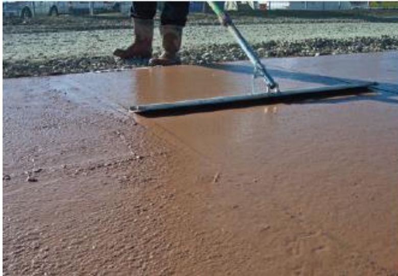
Figura 39. Enrasado de la superficie de la losa con regla manual de enrase.
