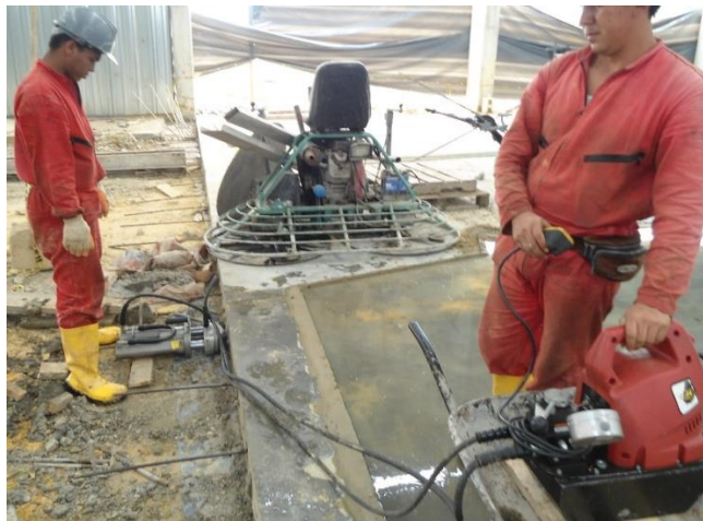
Figura 41. Tensionamiento de cables no adheridos
