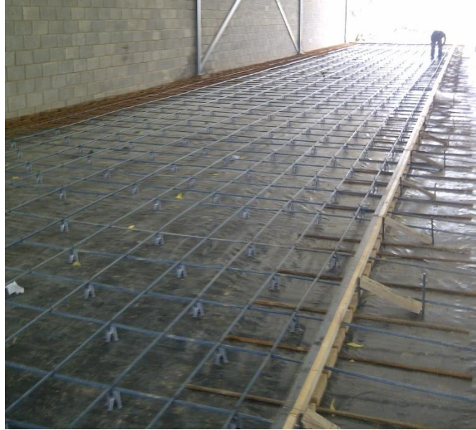
Figura 37. Armado de formaleta lateral para franjas de vaciado y armado de cables de presfuerzo
