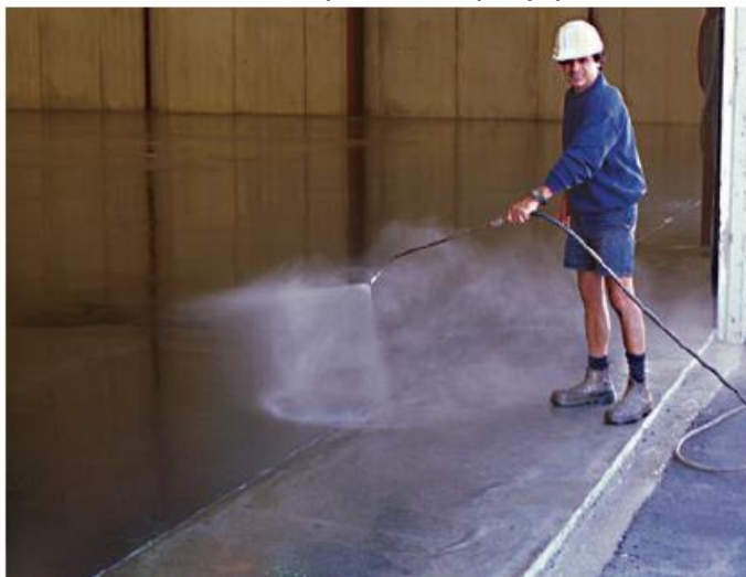
Figura 40. Aplicación de membrana líquida en spray para curado de losa
