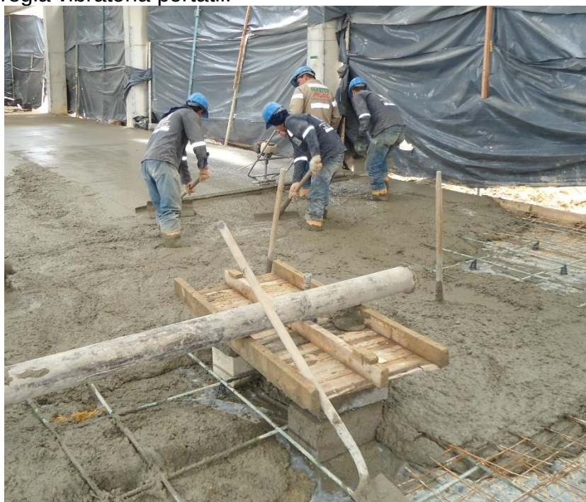
Figura 38. Extensión y compactado de concreto para losa con pala de puente cuadrada y regla vibratoria portátil.
