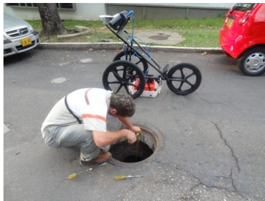
Figura 9. Verificación de la profundidad de la tubería mediante inspección.
