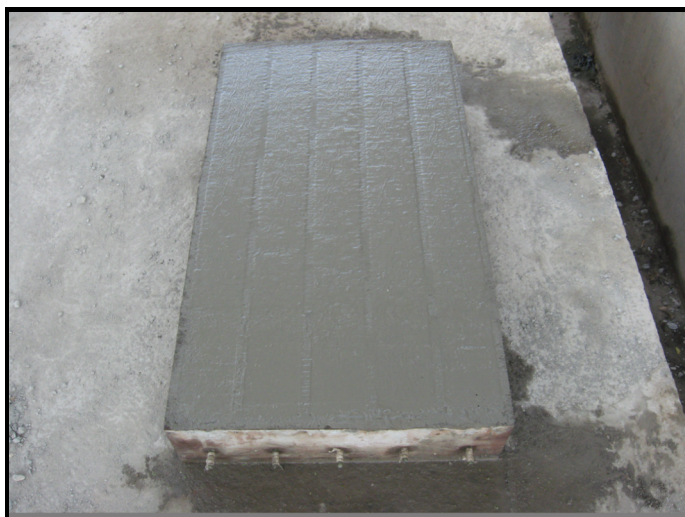
Fotografía 11. Colocación de la mezcla.
