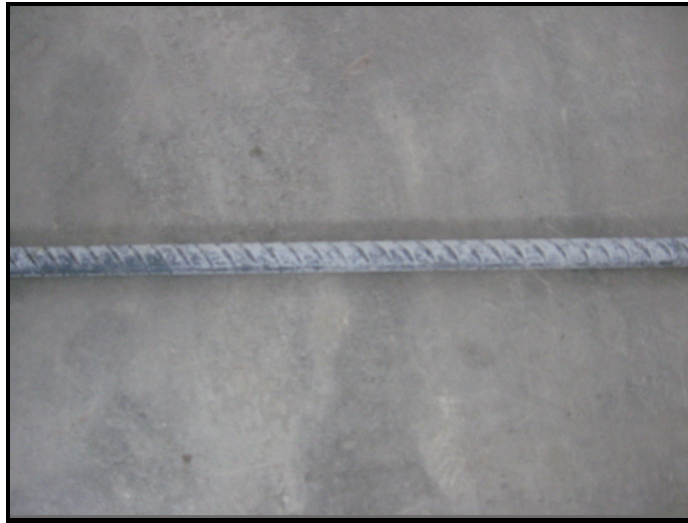
Fotografía 27. Varilla de refuerzo viga testigo.
