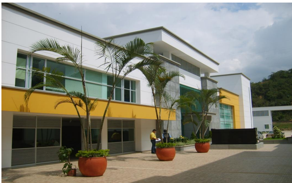
Figura 12. SEVICOL LTDA. Diseño y construcción sede administrativa y zona urbana
