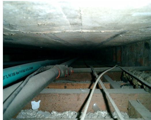
Imagen N° 5 Red de agua potable. ( Fría y Caliente)
