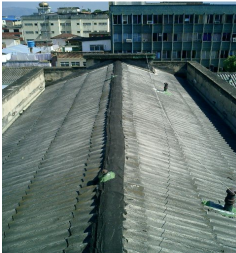
Imagen N° 8 Red de aguas lluvias.
