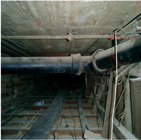
Imagen N° 7 Red Sanitaria y ventilación.
