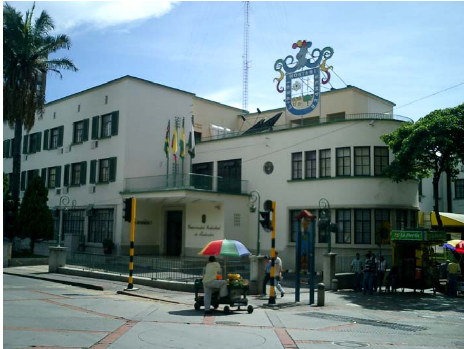
Imagen N° 1 Fachada Sede UIS Bucarica
