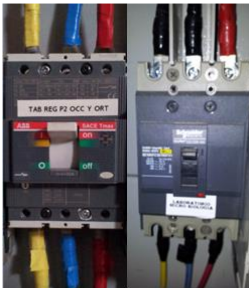
Figura 24. Interruptores termomagnéticos presentes en el TABLERO GENERAL REGULADO. A) Interruptor cto Lab Microbiología B) Tab Reg P2 Occ y Ort.
