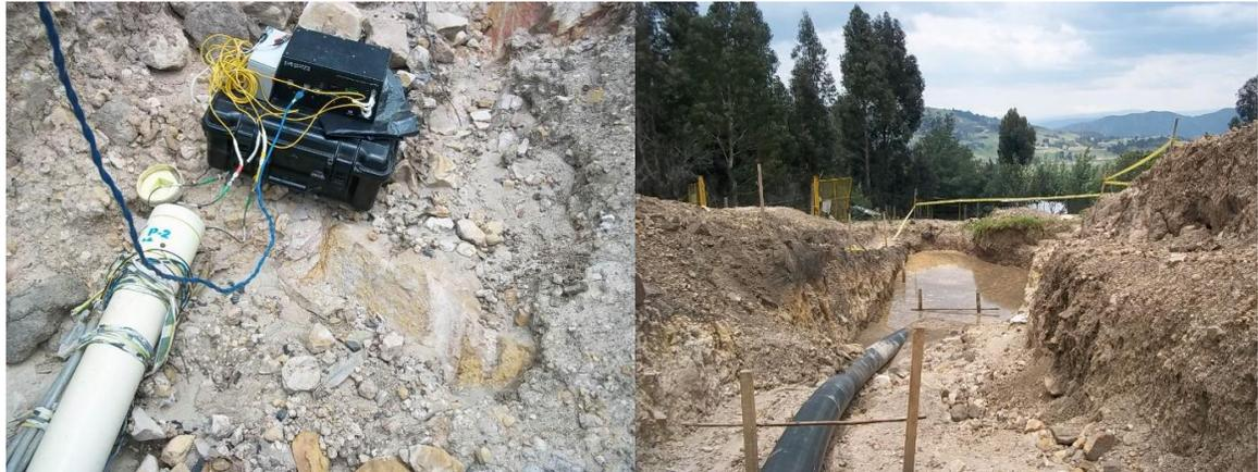
Este punto es el más crítico, ya que a pesar de lograr la liberación de esfuerzos a los cuales estaba sometido al momento de tener la configuración enterrada, presenta una condiciones distintas a las de diseño, tales como recubrimiento para tubería enterrada, inundación de la zanja y en general condiciones de seguridad no aptas para la zona donde se encuentra.
