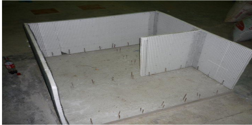
Foto 24: Colocación de muros internos
