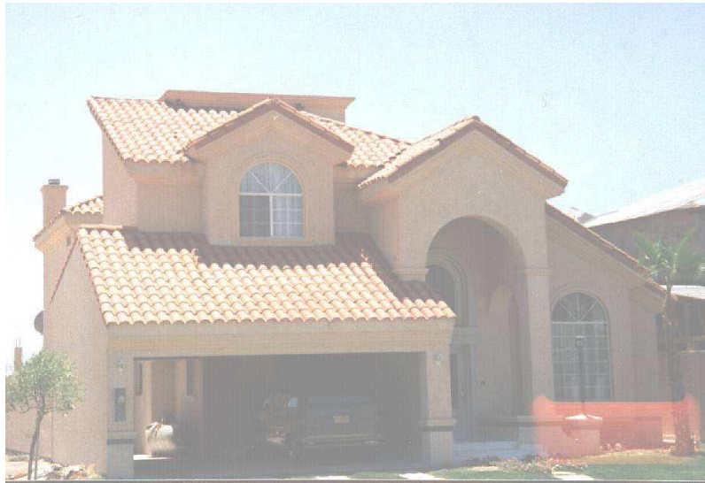
Foto 11: Vivienda terminada - Tridipanel
