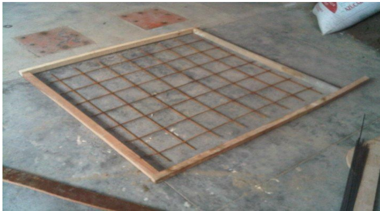
Foto 12: Cimentacion y anclajes
