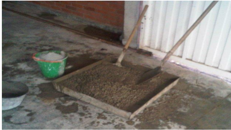
Foto 16: Preparación concreto para losa
