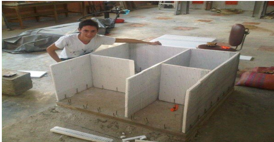
Foto 25: Paneles ensamblados completamente
