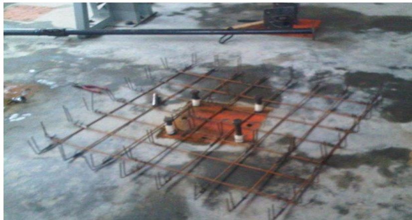
Foto 15: Ubicación placa de cimentación - piso
