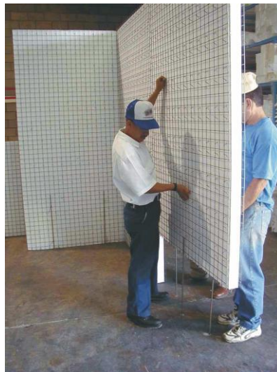
Foto 5: Ensamble de los paneles a la cimentacion
