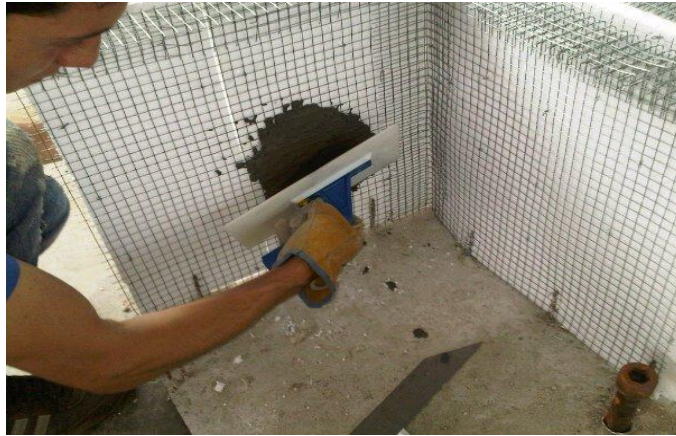
Foto 31: Inicio en la aplicación del mortero a los paneles.
