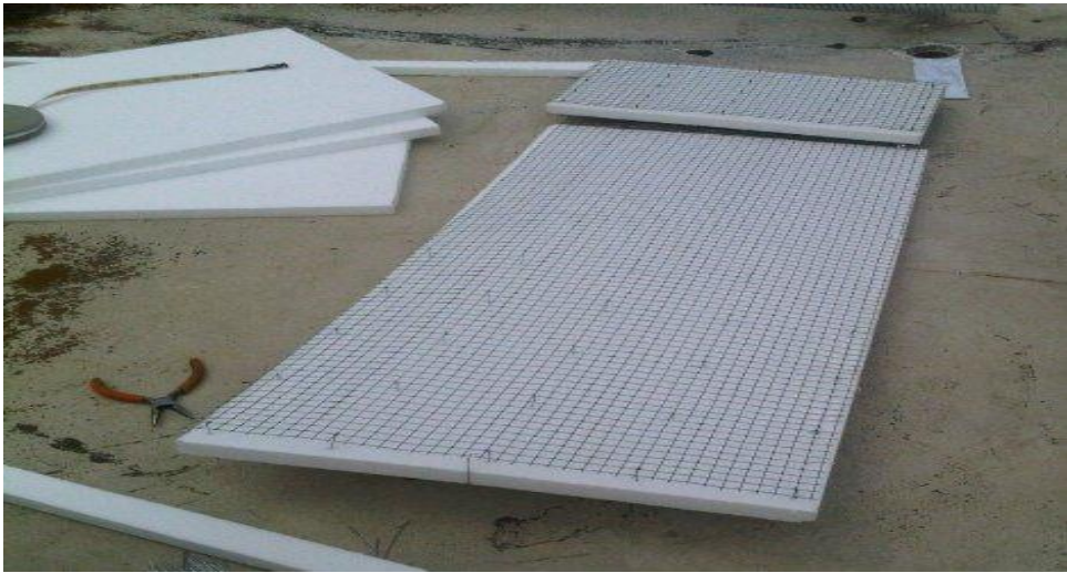
Foto 20: Fabricación del 3D Panel
