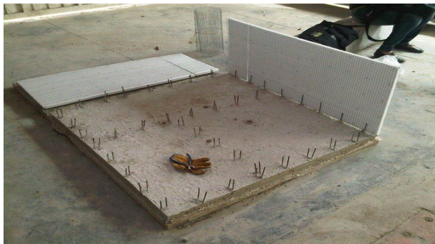
Foto 21: Ensamble de los paneles a la cimentación
