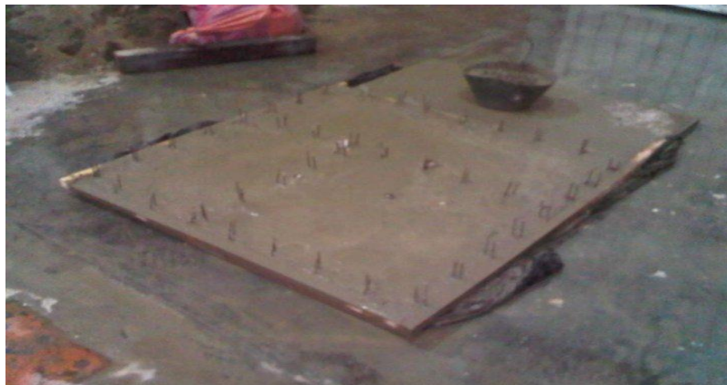
Foto 17: Curado losa de cimentación
