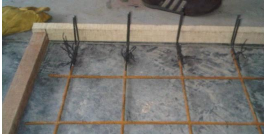
Foto 14: Amarre de anclajes
