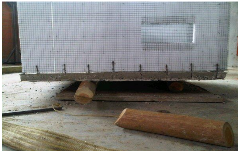
Foto 28: Traslado del modelo a escala al punto de anclaje al piso
