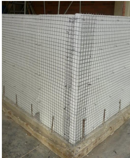
Foto 23: Unión entre paneles
