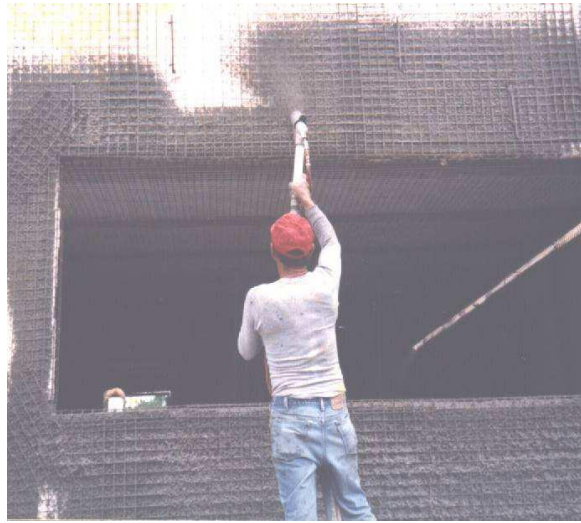
Foto 10: Proceso de lanzado húmedo mortero
