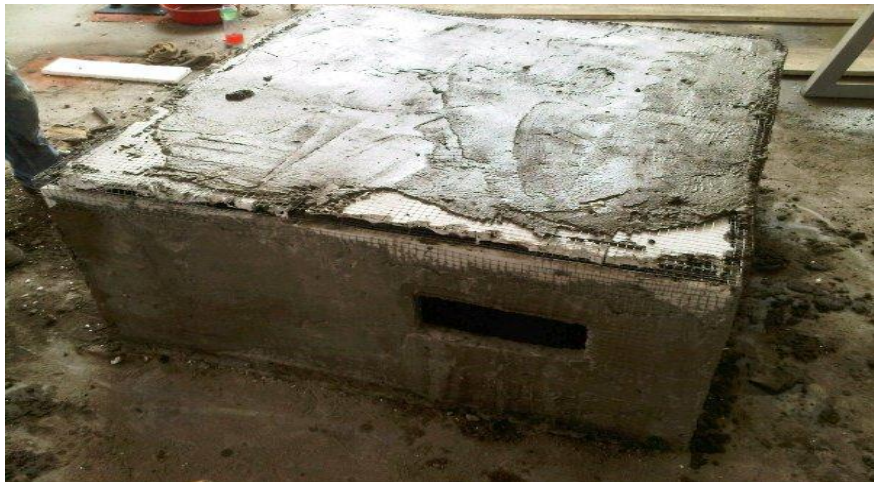
Foto 34: Amarre y aplicación del mortero a la cubierta.
