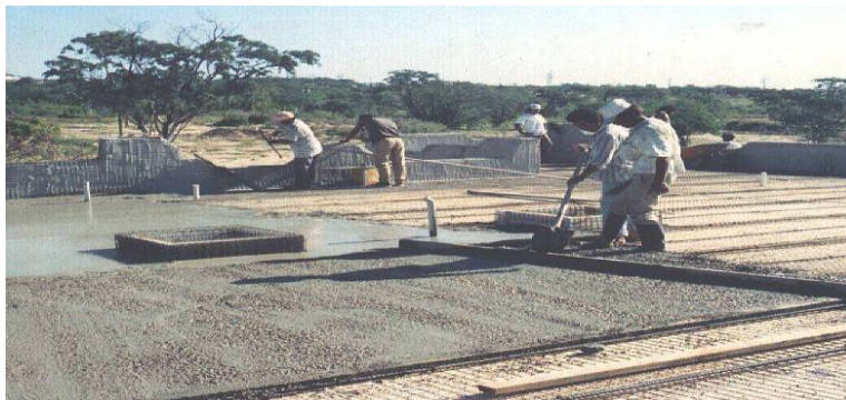
Foto 9: Panel de entrepiso o cubierta
