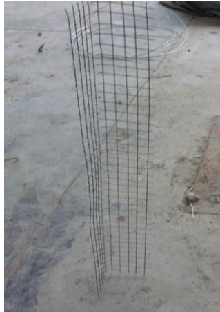
Foto 22: Malla de unión entre paneles
