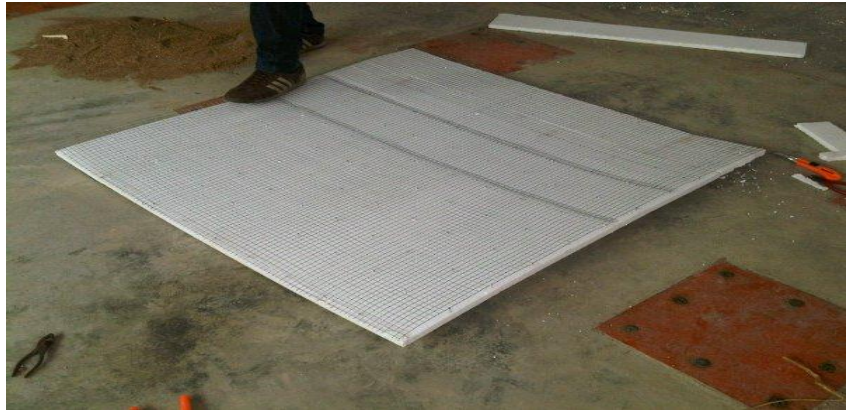
Foto 33: Armado y ensamble de cubierta.
