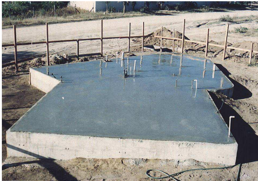
Foto 4: Placa de cimentacion
