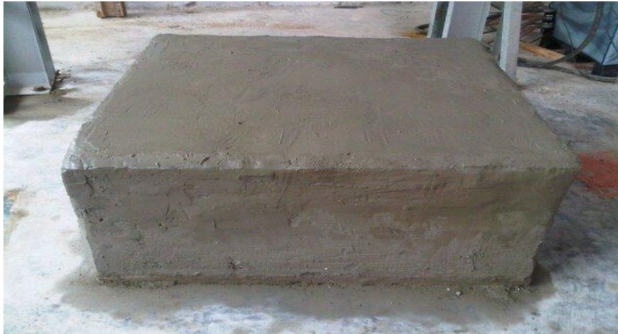
Foto 35: Acabado de aplicación del mortero.
