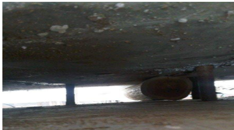
Foto 29: Ajustes pasadores verticales entre cimentación y piso
