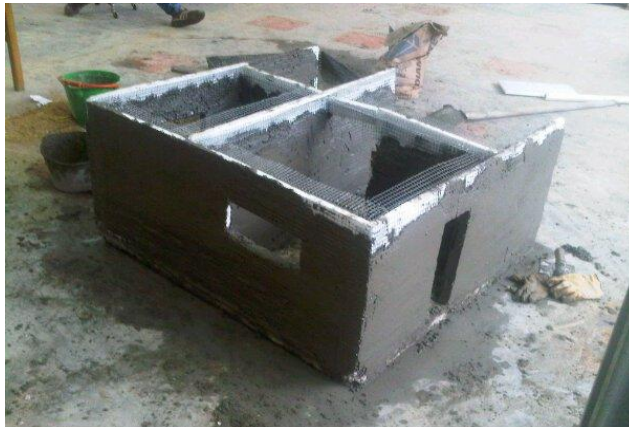
Foto 32: Avance en el acabado de los paneles verticales
