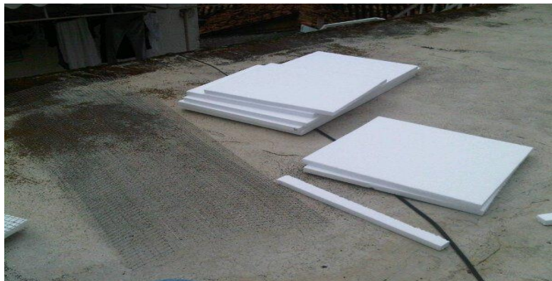
Foto 19: Poliestireno y malla de refuerzo
