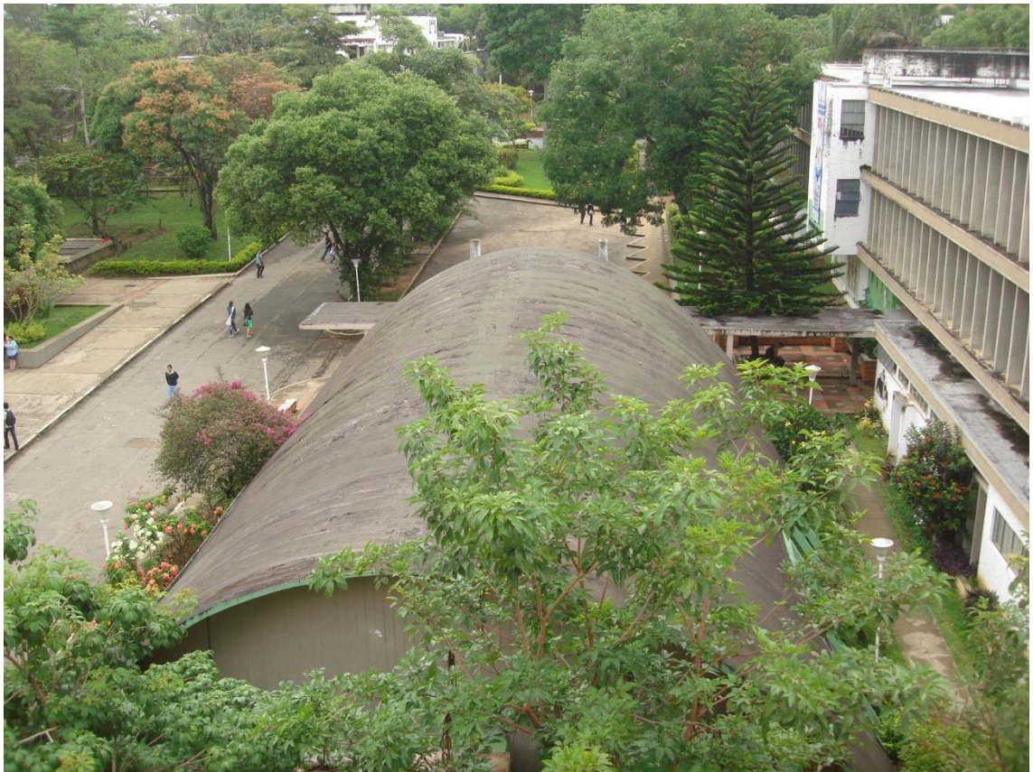
Figura 46. Auditorio de mecánica
