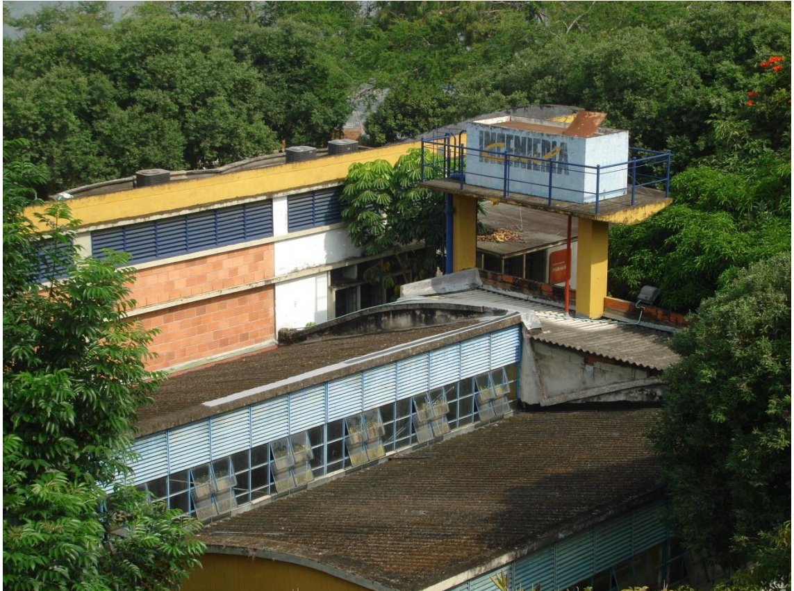
Figura 50. Laboratorios de Hidráulica
