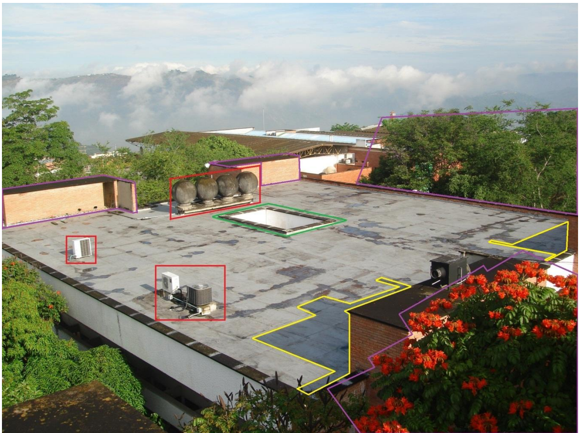
Figura 31. Obstáculos, equipos y entorno de un área disponible para implementar un sistema de paneles fotovoltaicos.
