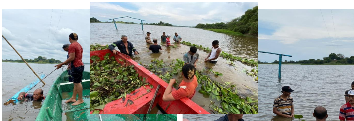
Figura 27. Obra finalizada en la Ciénaga San Silvestre
