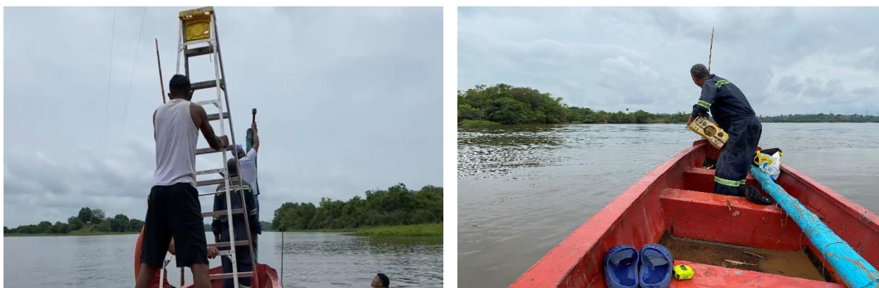
Figura 26. Proceso de realización de la obra III
