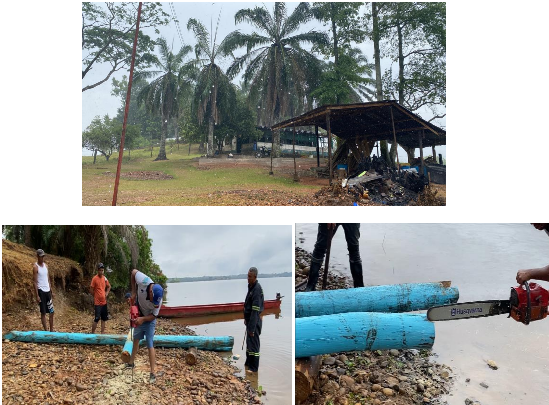
Figura 25. Proceso de realización de la obra
