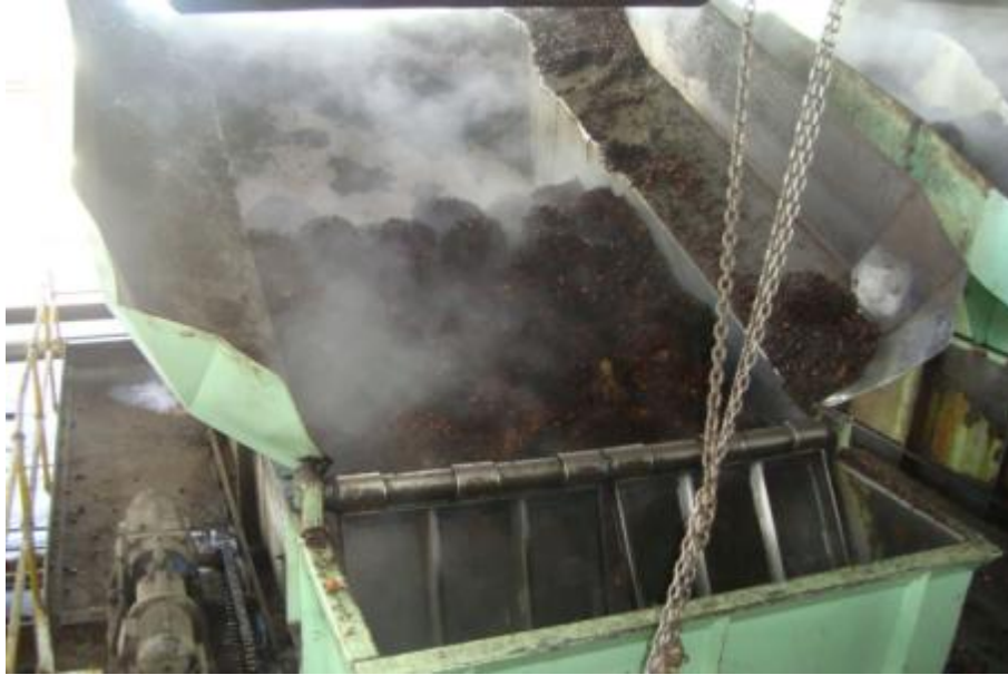
Figura 14. Variador de Tolva
