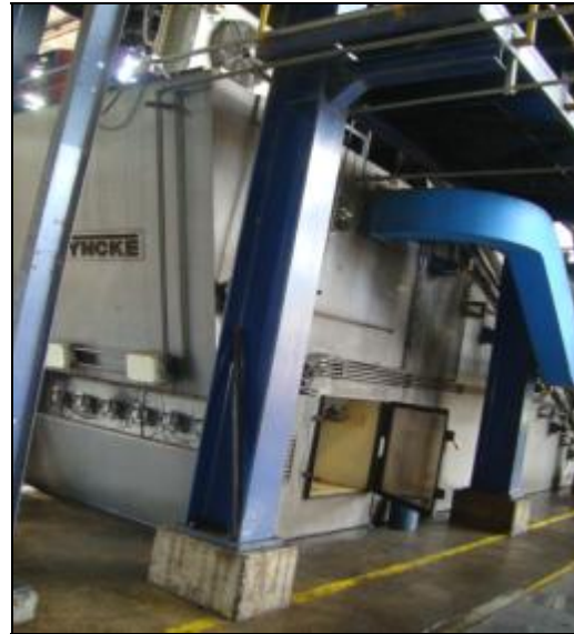
Figura 29. (a) Caldera Towler, (b) Caldera Vyncke, (c) Bombas Alimentación agua a las calderas.
