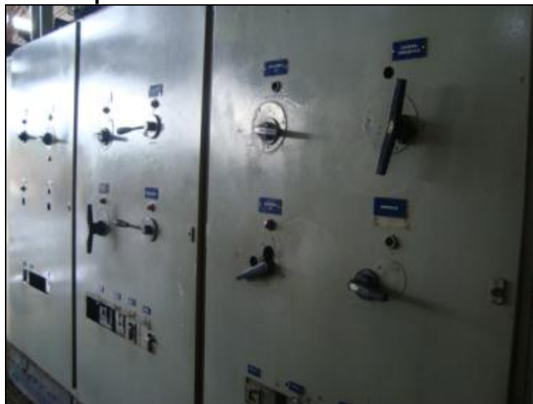
Figura 32. Sala de maquinas.
