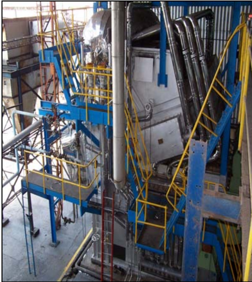
Figura 29. (a) Caldera Towler, (b) Caldera Vyncke, (c) Bombas Alimentación agua a las calderas.
