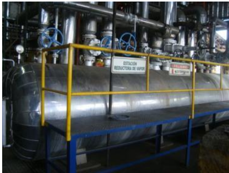
Figura 30. Distribuidor de vapor
