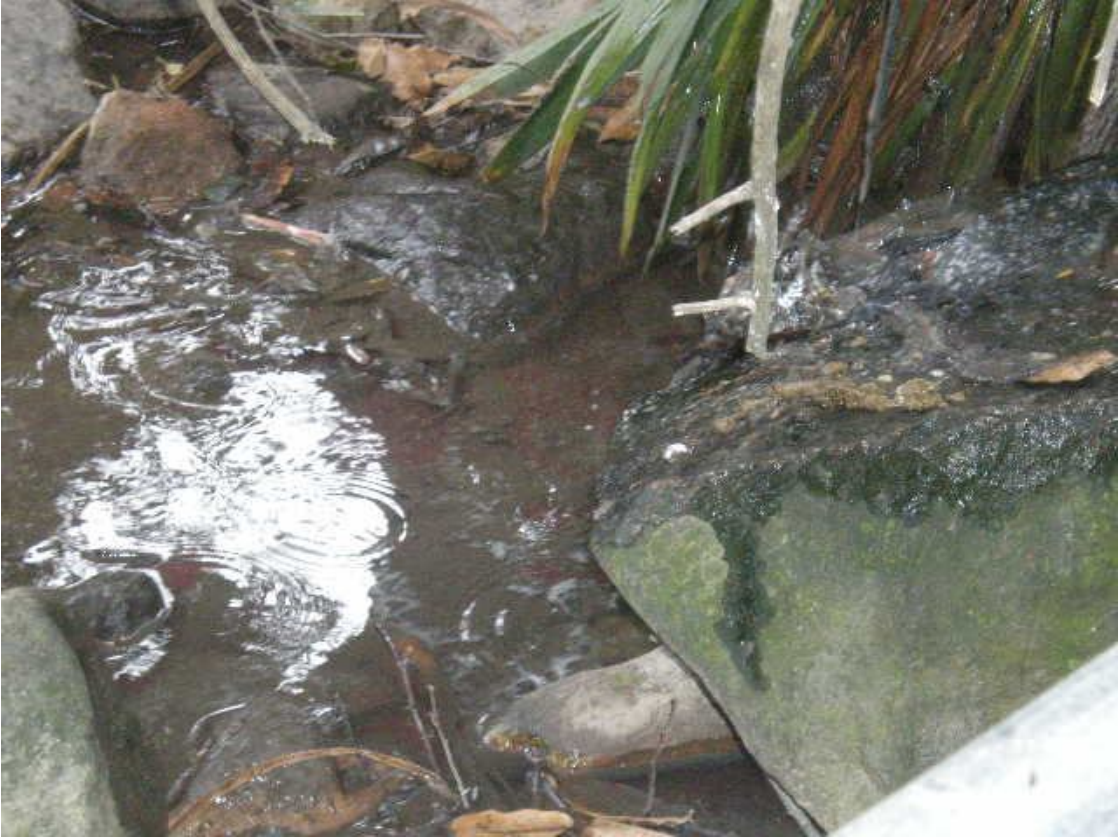
Foto F7. Vertimiento de aguas residuales domesticas provenientes de viviendas ubicadas sobre la ribera del Río Pómea en el Municipio de Arcabuco.
