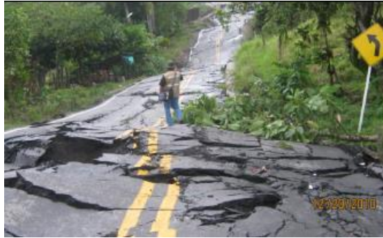
Figura 2. Falla en la vía Bucaramanga-Barrancabermeja, año 2010.
