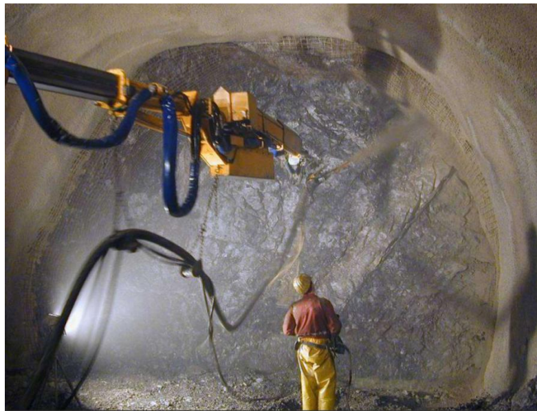
Figura 27. Aplicación vía húmeda.
