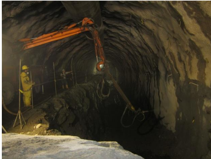
Figura 15. Lanzado de concreto vía húmeda.
