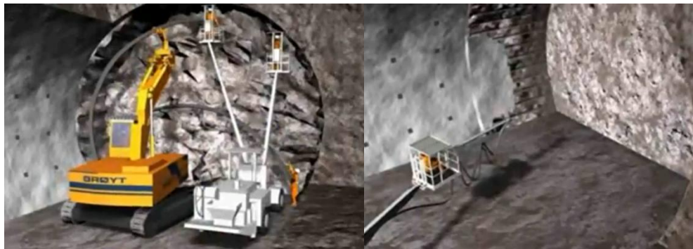
Figura 9. Instalación de arcos y proyección de concreto
