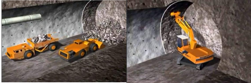
Figura 7. Retiro de rezaga, desabombe de bóveda y hastiales
