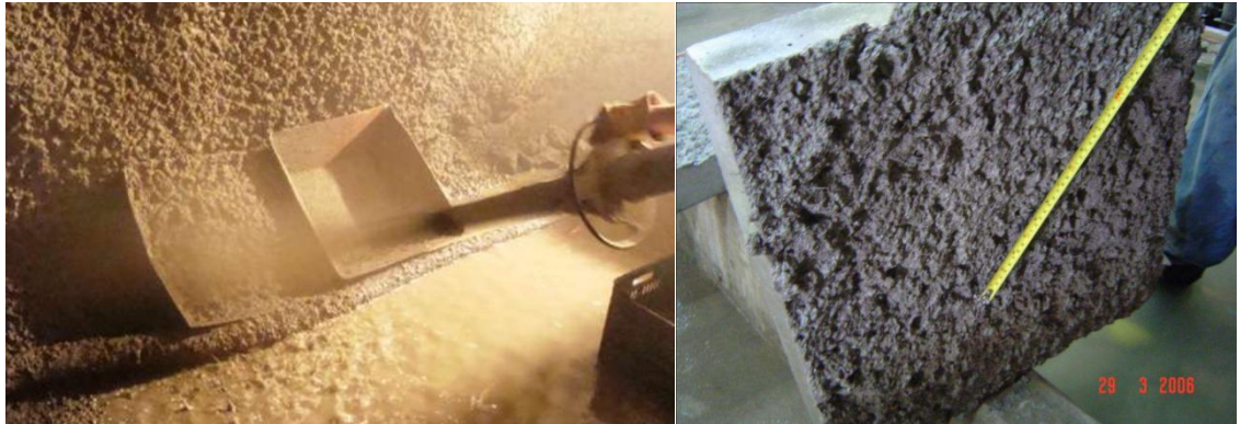
Figura 17. Elaboración de paneles de concreto lanzado.
