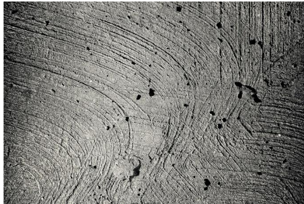
Figura 8. Estructura del concreto
