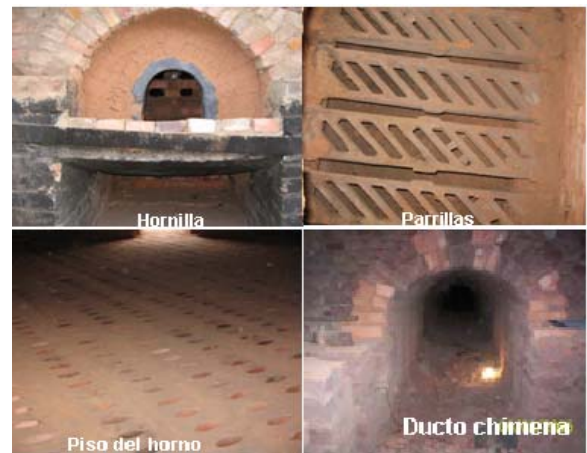
Figura. 2 Partes del horno colmena
