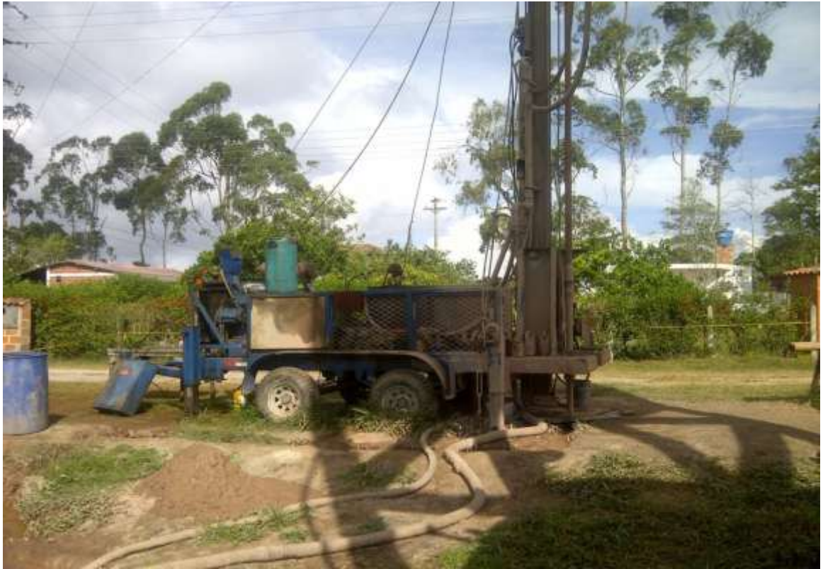
Figura 26. Fotografía de la extracción de ripios.
