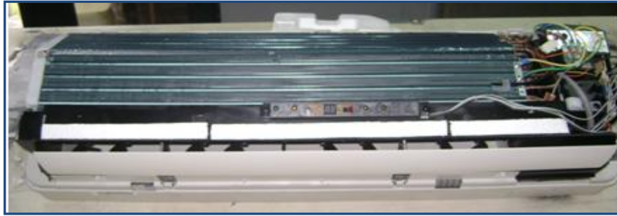
Figura 20. Evaporador
