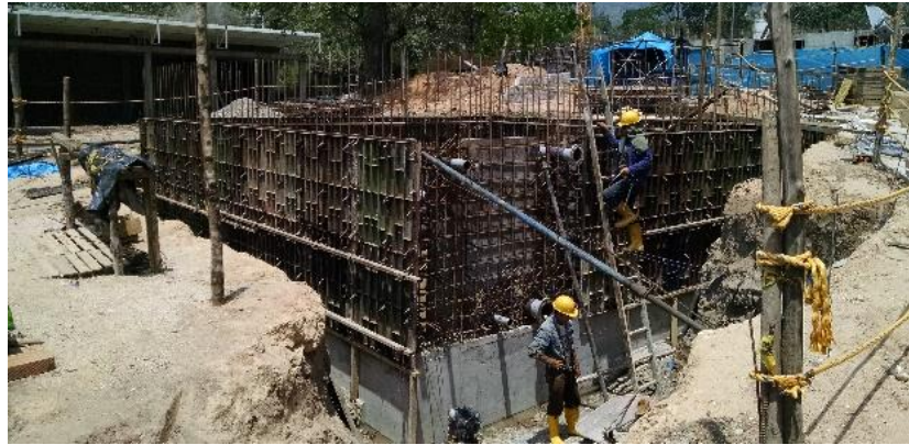
Figura 22. Tanque contraincendios.
