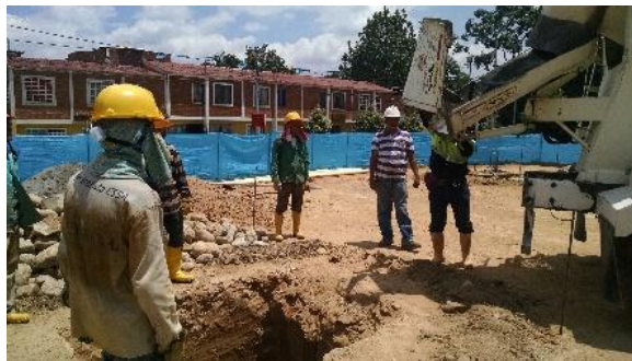
Figura 14. Fundida de concreto ciclópeo
