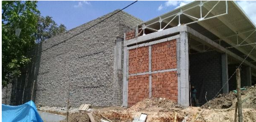
Figura 18. Mampostería del proyecto.
