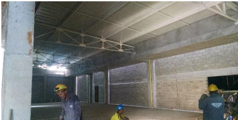
Figura 25. Estructura metálica y cubierta.
