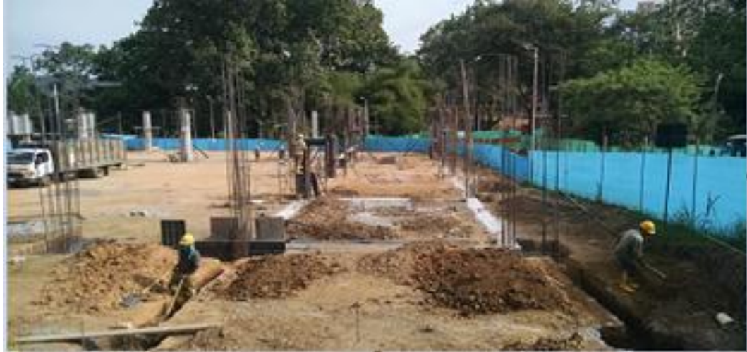
Figura 15. Armado de columnas.
