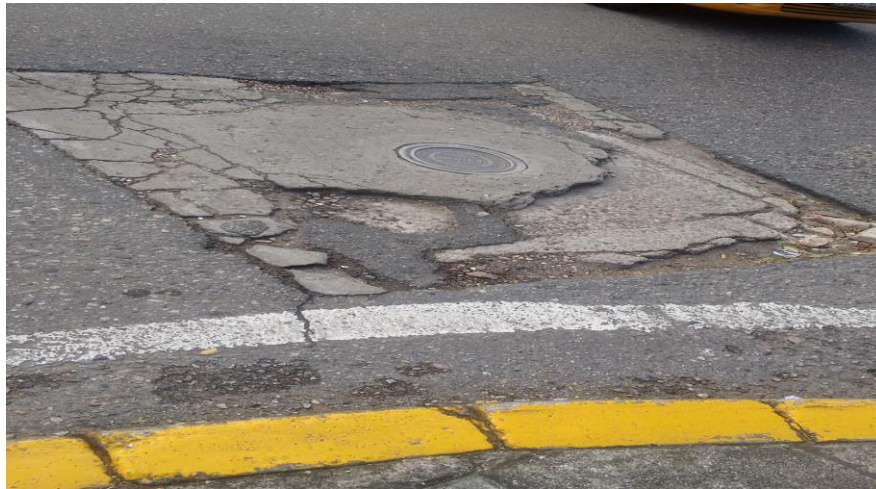
Figura 20. Alcantarilla en la calle 54 con cra 33.
